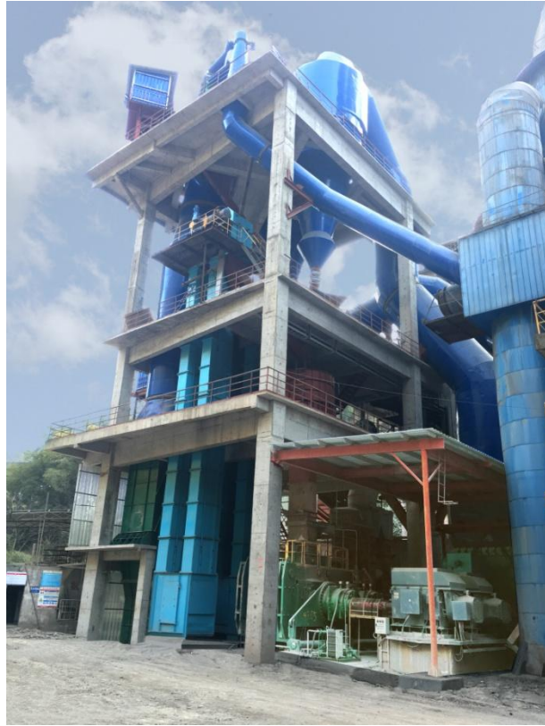
图8 生料辊压机终粉磨胶带提升机使用现场
