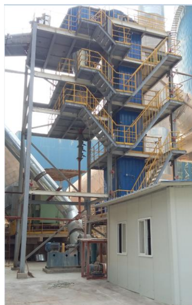
图 6 水泥窑 SCR 脱硝装置图
