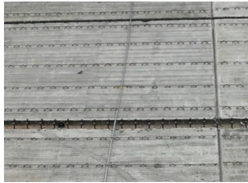
图 1 钢筋桁架叠合板
