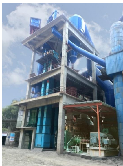
图 12 改造后的生料辊压机循环胶带提升机
