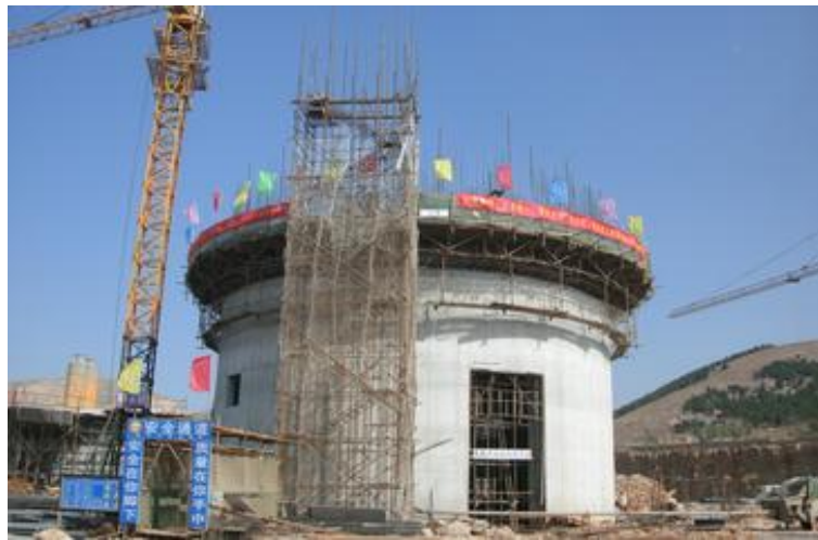
怀远中联水泥厂 4500t/d 熟料生产线均化库滑膜施工
