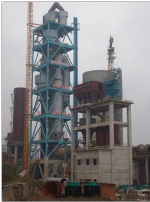
临汾山水水泥厂 4500t/d 熟料生产线窑尾安装
