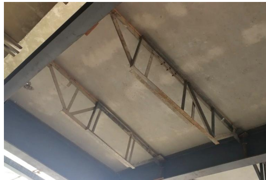
图 2 叠合楼板与桁架支撑
