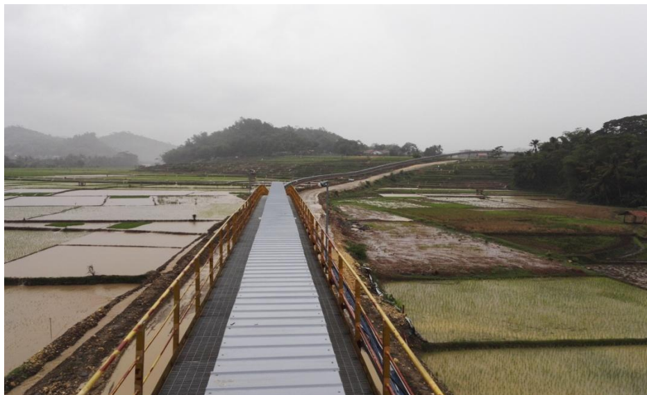
图片 1 印尼某水泥厂输送石灰石用的 D350 圆管带式输送机穿过农田和村庄
